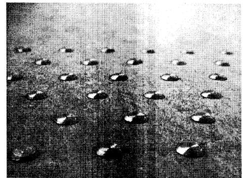
Para ello se requiere la utilización de botones podotáctiles, de acero inoxidable, con textura y antideslizante, los cuales se instalan en pavimentos existentes, anclados y adheridos con pegamento epóxico. Cada botón es de 35 mm de diámetro x 5 mm de alto, además contempla un anclaje de 12 mm de profundidad que se introduce al pavimento junto al pegamento epóxico.
